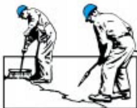
PREPARACIÓN DE LA JUNTA O GRIETA
